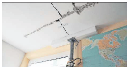
Risse in einem von den Erdhebungen mitgenommenen Haus: Die Debatte um die Entschädigung der Betroffenen hält an Foto: Thomas Bischof
