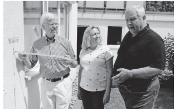
Böblinger CDU-Stadträte bei der Begutachtung von Gebäudeschäden wegen unsachgemäßer Erdwärmebohrungen
