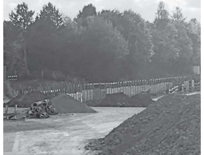
Baustelle an der Herrenberger Straße für die Unterführung der Schönbuchbahn
